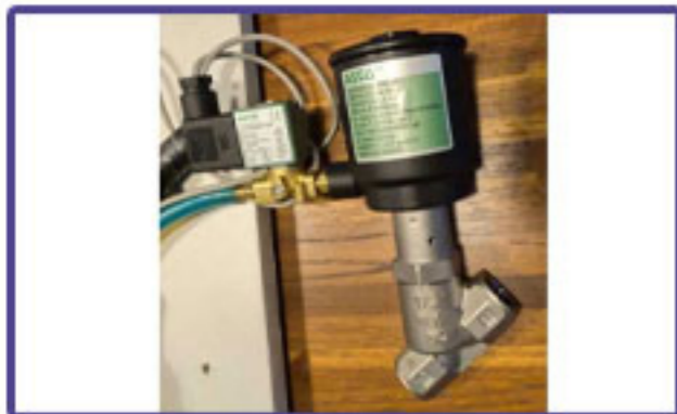
การต่อใช้งาน Solinoil Valve 3/2 ไปใช้งาน Piston Valve
